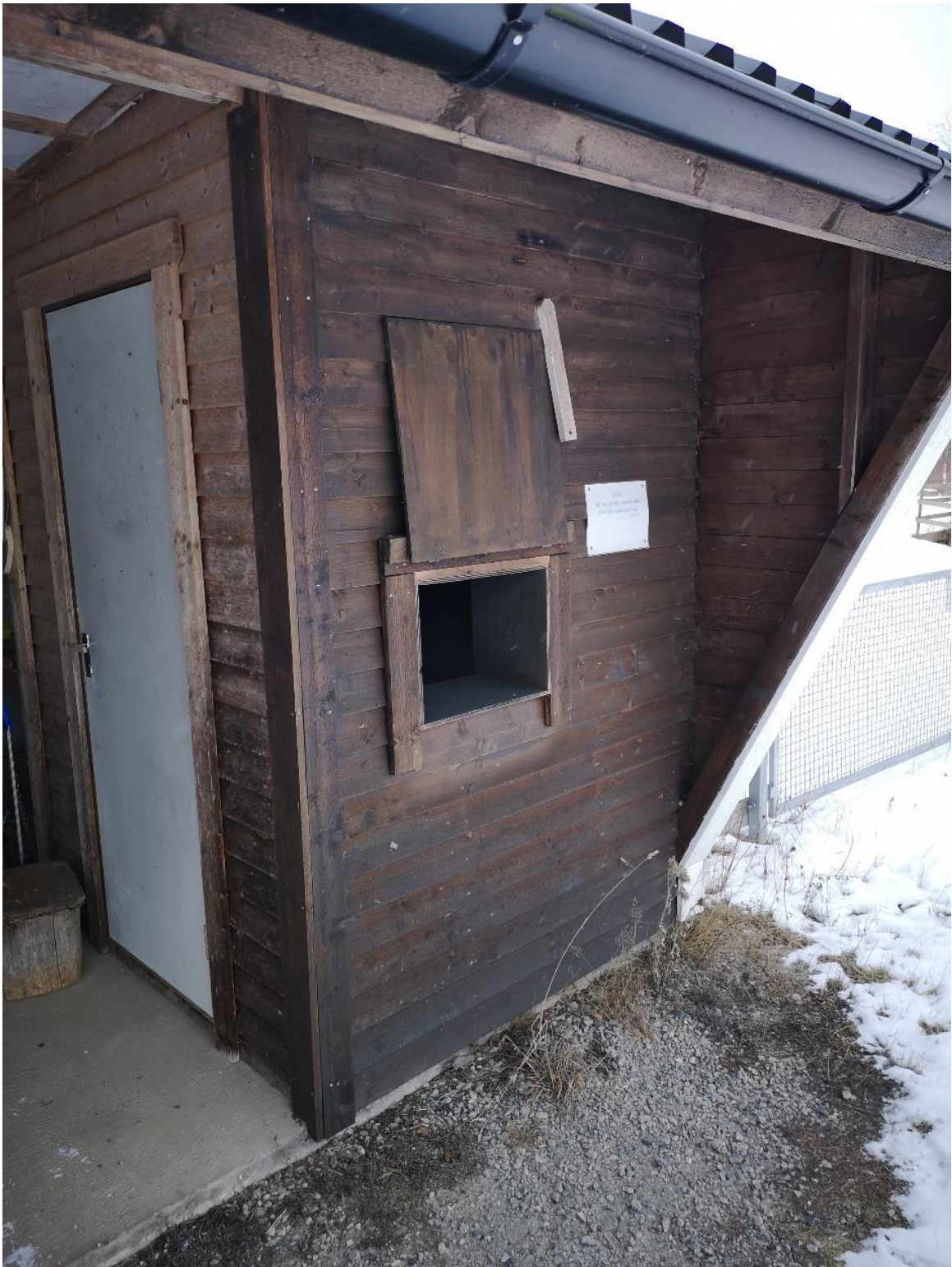
Figur 5 Skjuthall vid viltmålsbana 80 m med sidoväggar. Denna skjuthall har bedömts att uppfylla dimensionerna för skjuthall av typ "Dalgas 3 m" alternativt "Dalgas 5 m", se Figur 6.
